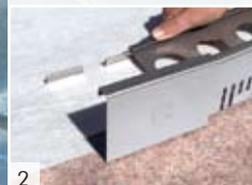
Die im Bedarfsfall eingekürzten DP-Profile werden anschließend einfach in den Halter eingeklipst.
