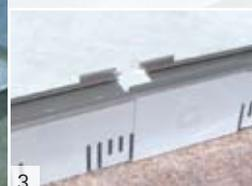
So verbaut, kaschiert der Halter die Stöße bzw. die im Einzelfall durch Ablängen entstandenen Schnittkanten der DP-Profile. Es entsteht ein einheitliches und sauberes Erscheinungsbild.
